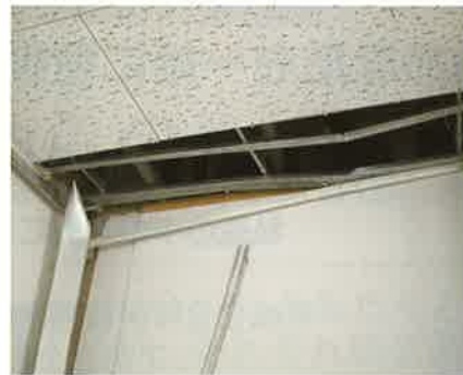
施設内の天井及び壁が被災し補修をしながらの業務再開となりました
