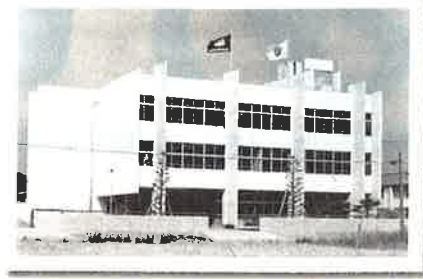
昭和46年11月 新校舎を竣工 昭和48年9月 看護科を開校し准看護科との一貫教育を開始。 昭和49年9月 日立メディカルセンター看護学院が誕生しました。
