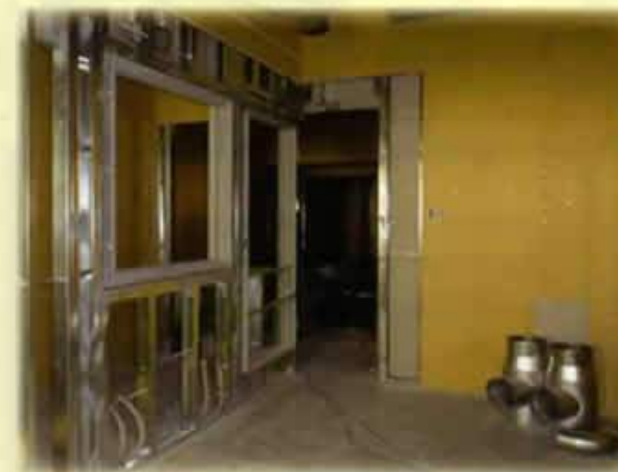
レントゲン室
